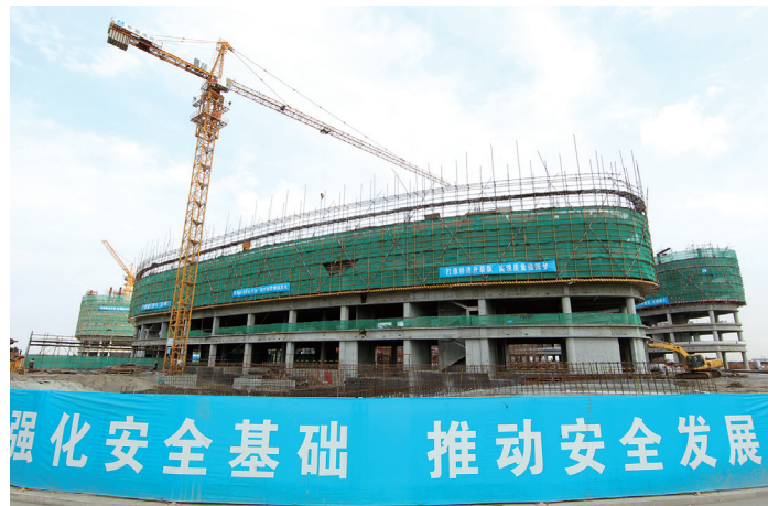
▲ 建设中的总装制造中心浦东基地
