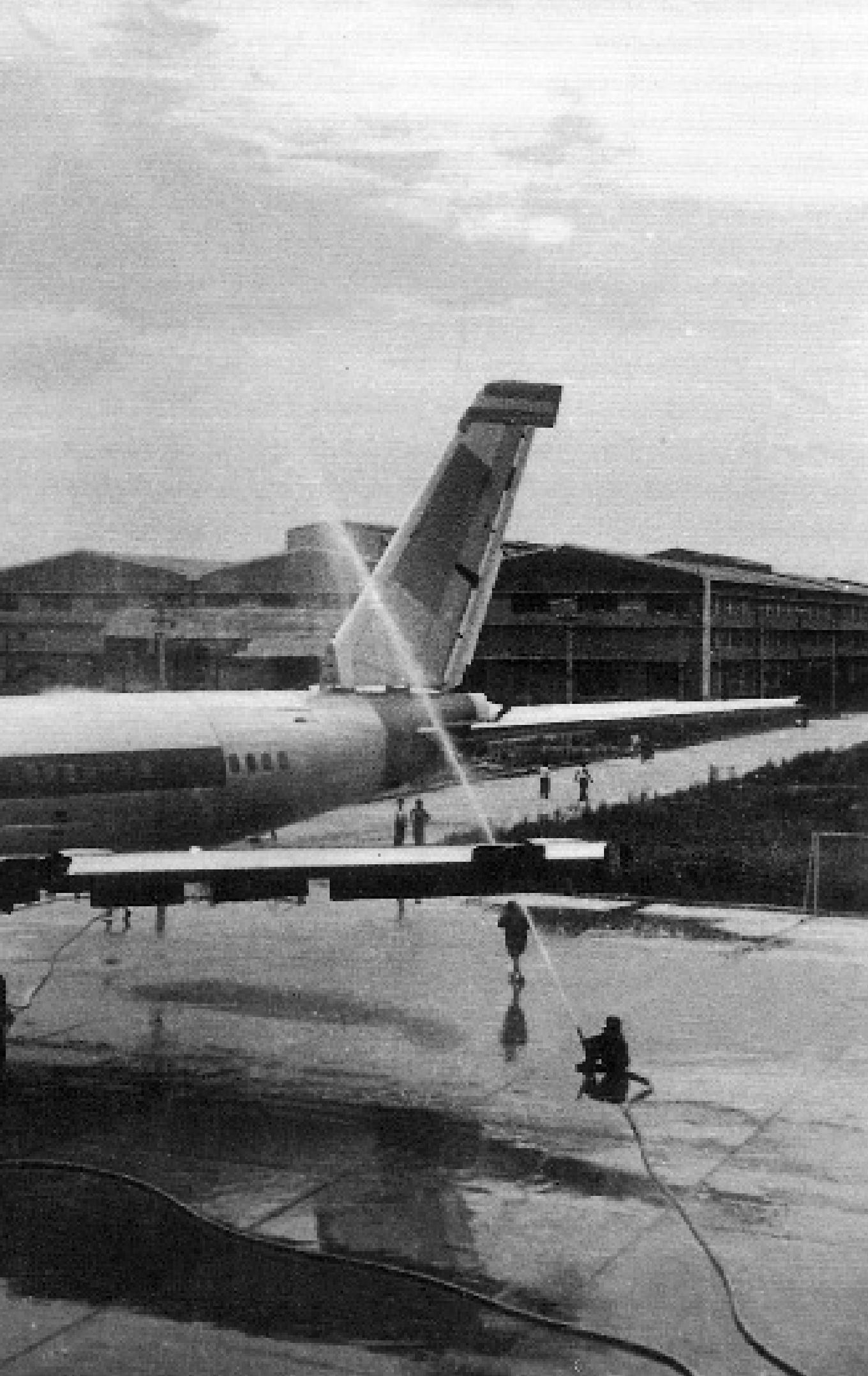
运十飞机正在做淋雨试验
