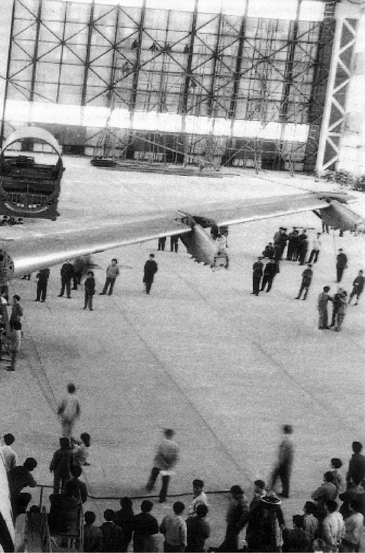
机翼整体吊运进入纵向对接台就位
