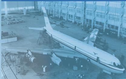
• 运十飞机的研制成功，使我国拥有了自己设计制造大型飞机的复杂技术，这不仅填补了我国民航工业以前不能制造大型飞机的空白，而且使我国一举成为继美、前苏联、英、法之后，第五个研制出 100 吨级飞机的国家。此外，在运十飞机研制的 10 年中，上海还同步研制成功了与 JT3D-7 性能相当的 915 发动机，并成功地装在飞机上作了飞行试验。
